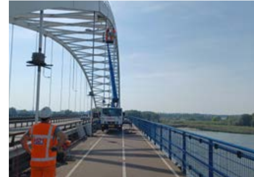
Afb.: Veilig werken op hoogte vanaf het vrijliggende fietspad in plaats van op de rijbaan. Veiliger voor de uitvoerende partij en voor het langsrijdend autoverkeer.
