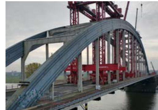
Afb.: Tijdelijke ondersteuningsconstructie geschikt ten behoeve van stabiliteit tijdens uitvaren maar ook voor het lokaal veilig demonteren van de boogbrug.
